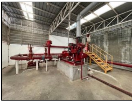
รูปที่ 2-55 เครื่องสูบน้ำดับเพลิง (Fire Pump)
